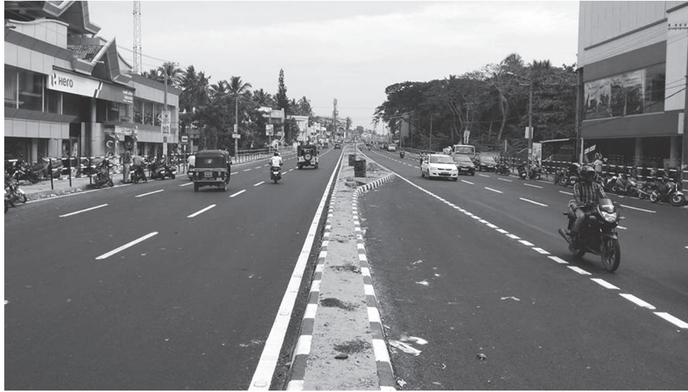
ദേശീയപാതയിലെ കരമന- കളിയിക്കാവിള റൂട്ടിൽ കേരള സർക്കാർ തന്നെ 30 മീറ്ററിൽ നിർമ്മിച്ച നാലുവരിപാത. 45 മീറ്റർ ബി.ഒ.ടി പാതകൾക്ക് പകരം ഈ രീതിയിൽ ദേശീയപാത വികസിപ്പിക്കാനാണ് സമരപ്രവർത്തകർ ആവശ്യപ്പെടുന്നത്.
